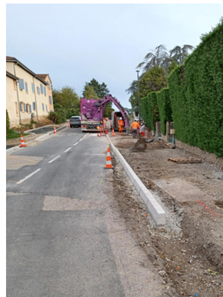
Requalification rue du Falque Dommartin
