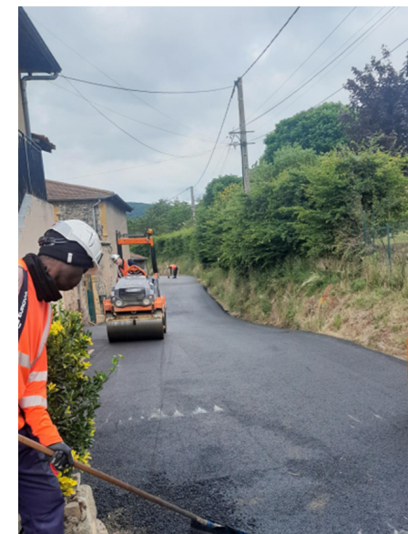
Réfection de la couche de roulement Chemin Du Planin – Bibost
