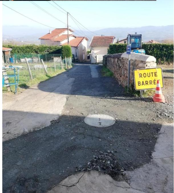
**Nature et descriptif de l'opération :** création d'un réseau EU strictes en diamètre 200 mm sur environ 700 mètres linéaires permettant le raccordement de 16 logements à la station de Bibost.
