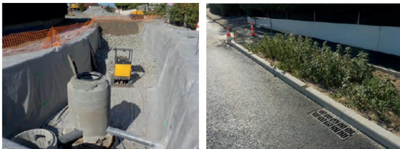
Lors des travaux, la CCPA a modifié la gestion des eaux pluviales auparavant collectées par les réseaux unitaires ou pluviaux. Les pluies courantes sont désormais infiltrées dans le sol. Pour les événements pluvieux importants pour lesquels le sol n'est pas en mesure d'infiltrer la totalité de l'eau de pluie, le surplus sera dirigé vers des ouvrages de rétention avant rejet au réseau d'eaux pluviales.
