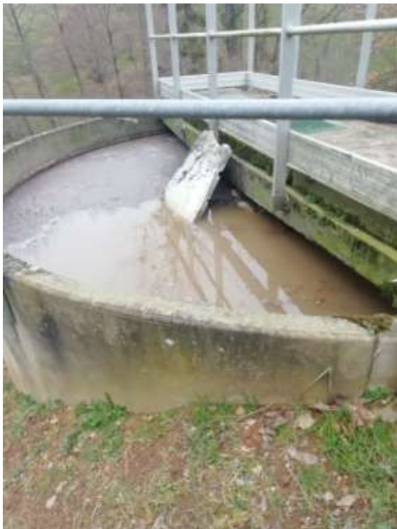
Vétusté du décanteur-digesteur : vidange et remise à neuf de la coupole en inox
