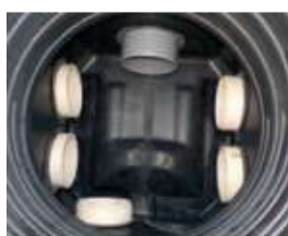
Ex. regard de répartition
