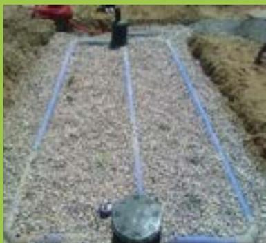
Travaux d'assainissement non collectif : filtre planté (à gauche) et lit d'infiltration des eaux traitées (à droite)
