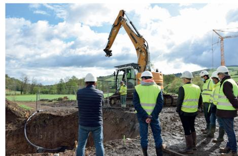
A terme, le fonçage va permettre d'amener les eaux usées de l'ancienne station vers la nouvelle et, permettra également d'accueillir le tuyau qui permet de renvoyer les eaux épurées vers la Brévenne.
