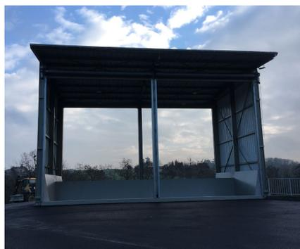
Les camions déversent les ordures ménagères au quai de transfert, situé sur le site de la déchèterie de Fleurieux sur L'Arbresle. Les ordures ménagères sont ainsi déversées par gravité dans des semis de 90 m<sup>3</sup>. Fin 2018, le SYTRIVAL a engagé des travaux de rénovation du quai incluant la couverture par un auvent, l'installation d'un pont bascule et la reprise de la chaussée.
